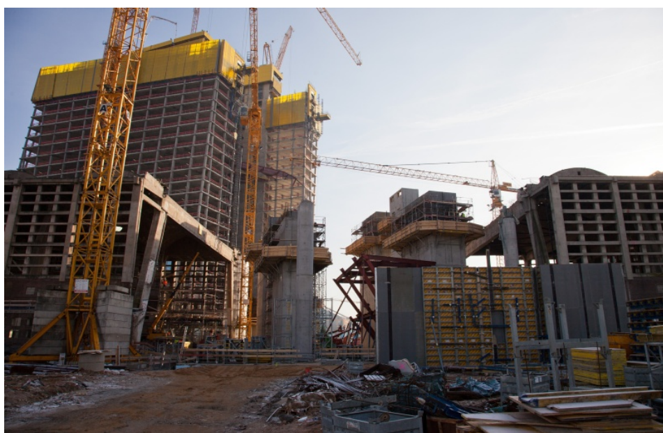
Ilustracja 69 Roboty fundamentowe pod budynek wejściowy
